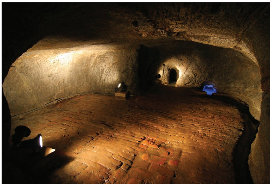
Vlašim – ústí bývalé únikové chodby a odvodňovací štolý
